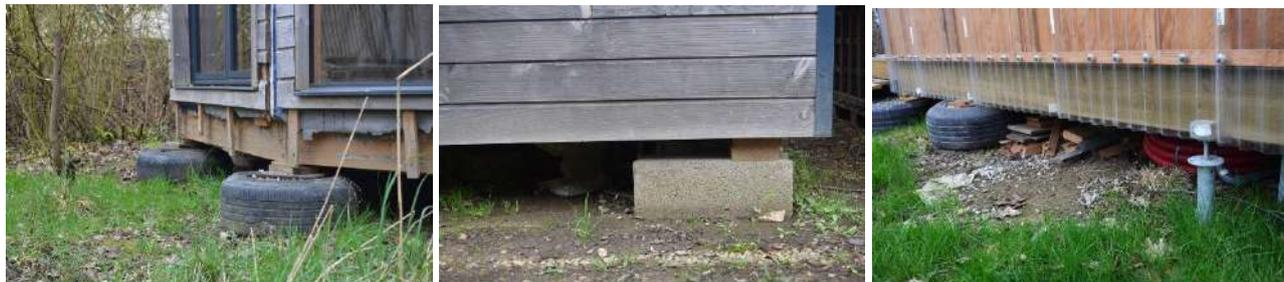
Différents types de fondations réversibles : pneus remplis, parpaings, vis de fondation
